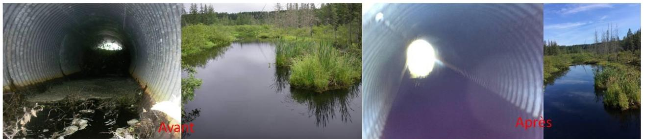
**Figure 5 : Barrage de castor construit dans un ponceau**
