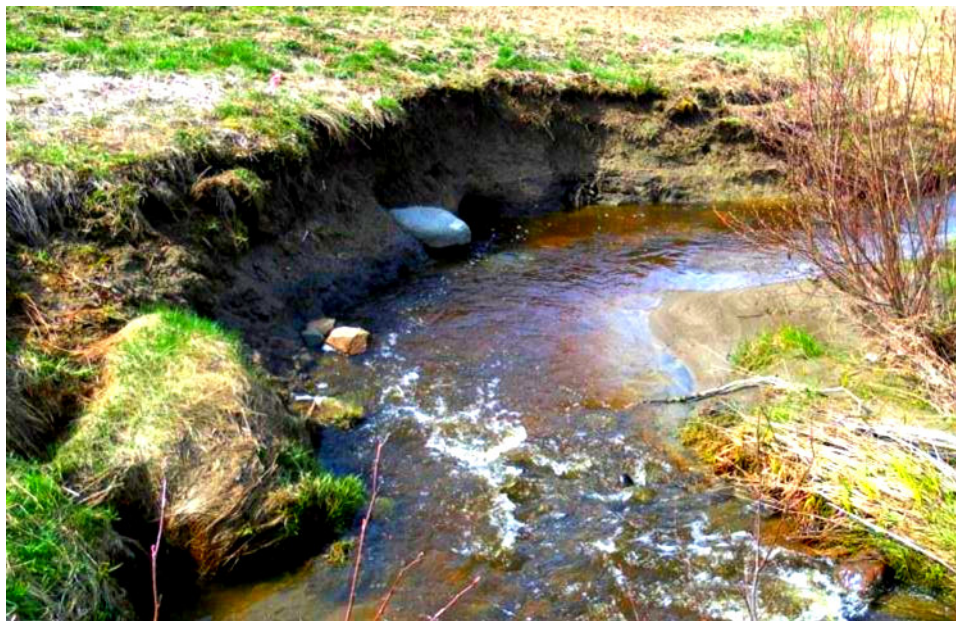
Figure 26. Ravinement des berges.
