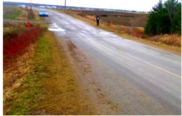
(b) Photo # 76, montrant la route et fossé
