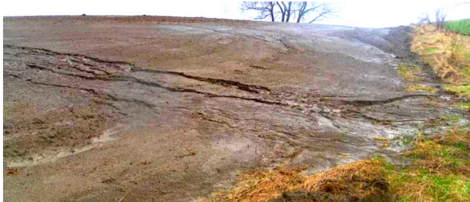
Figure 35. Ravinement au champ connecté à la berge
