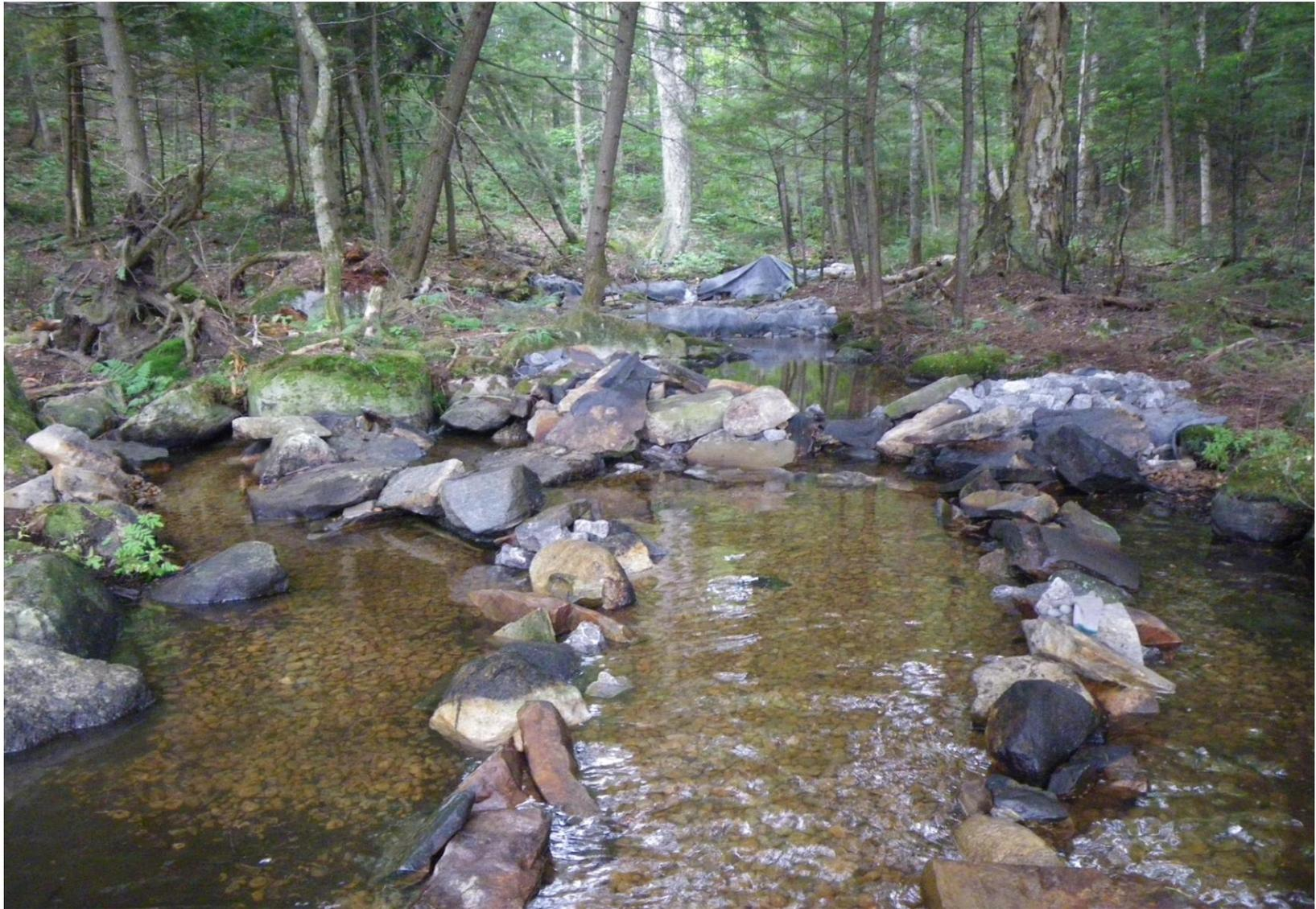
Figure 5 - Vue après aménagement d'un tronçon de cours d'eau. La frayère près de l'embouchure a été réalisée en « canal » plus étroit de façon à concentrer de débit et aider à garder le gravier propre.
