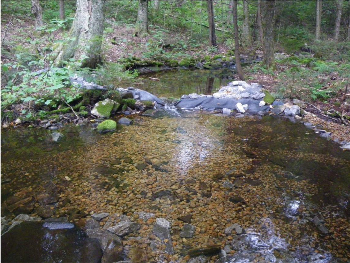
Figure 13 - Les frayères de type « dynamique » sont réalisées par dépôt de gravier de rivière sur une épaisseur variant de 10 à 15 cm.
