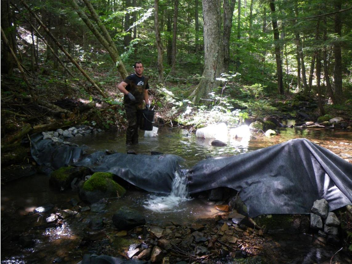
Figure 12 - Lors de la mise en place du géotextile, le lit du cours d'eau doit être uniforme, sans aspérité. C'est cette membrane qui fait l'étanchéité et incidemment, être en mesure de retenir une colonne d'eau intéressante (30 cm environ) pour l'habitat du poisson
