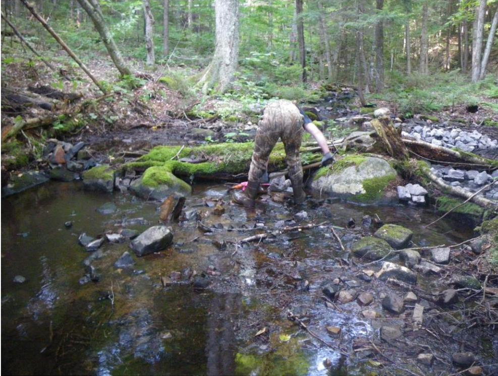
Figure 3 - Vue du cours d'eau principal du projet avant la construction d'un seuil ; on fait du nettoyage de débris ligneux et on dégage les pierres naturelles présentes sur le site, qui seront réutilisées lors des constructions.
