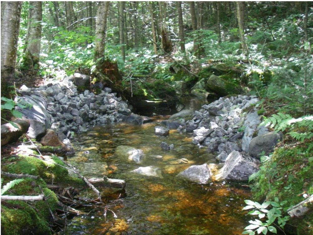
Photo 19. Stabilisation du seuil avec la pierre (vue de l'amont).
