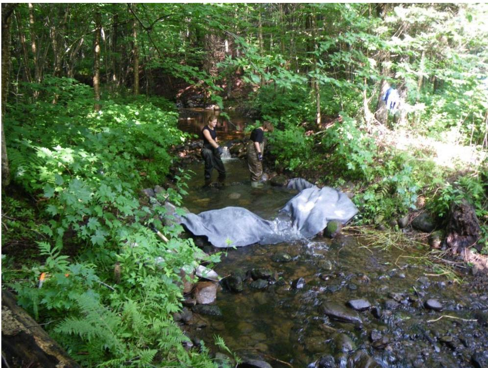
Photo 3. Installation du géotextile sur la base de pierres.
