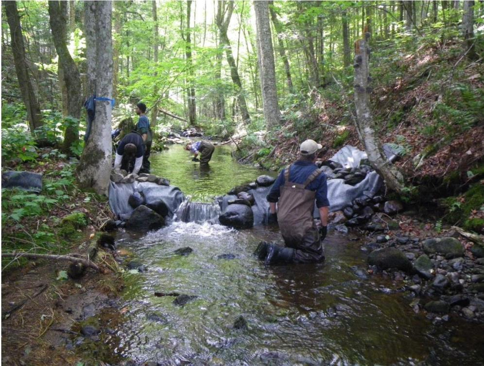
Photo 8. Construction du quatrième seuil.
