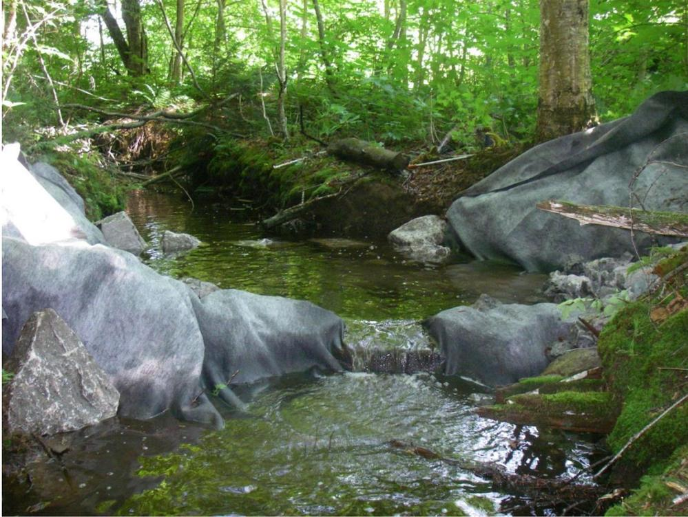
Photo 18. Installation du géotextile sur la base.
