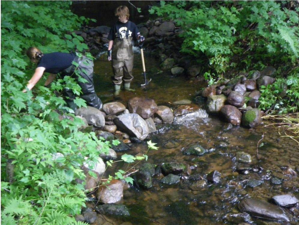
Photo 2. Construction de l'assise du seuil aval.
