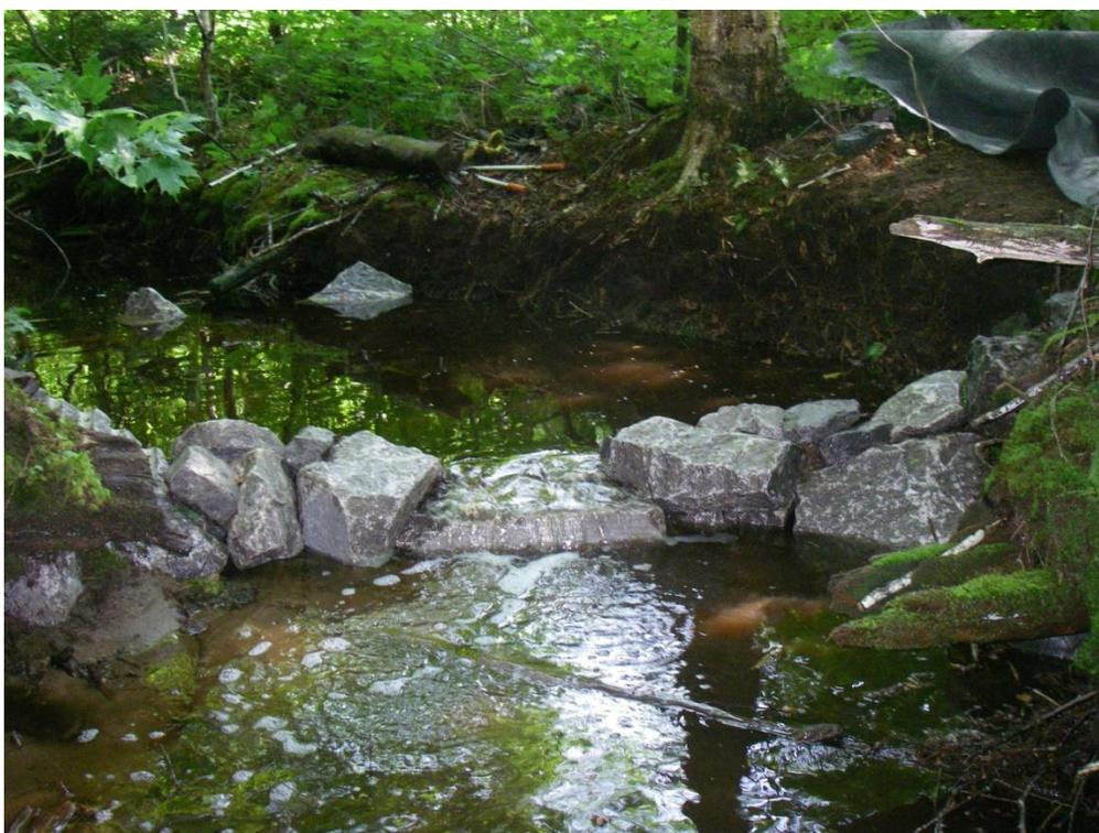
Photo 17. Construction de l'assise d'un seuil.
