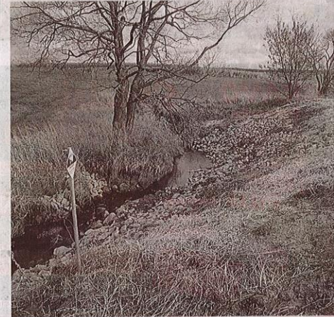
La CAPSA a soutenu des producteurs agricoles dans la mise en place de mesures de protection de l'eau à Saint-Basile et à Pont-Rouge. PHOTO - CAPSA
