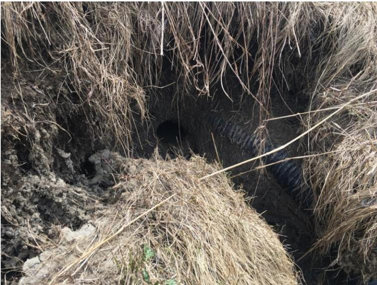
**Ils causent aussi de l'érosion par ravinement, des bris de drains et des problèmes de fonctionnalité de système\$.**
