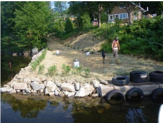
En collaboration avec les Religieux St-Vincent de Paul, la CAPSA a procédé à la stabilisation et la renaturation d'une section de la berge présente sur le site du Camp de Vacances. Les travaux ont consisté au retrait d'une section du muret de béton, à la stabilisation de la rive et à la renaturation de la berge.
