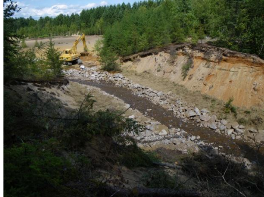
Durant les travaux
