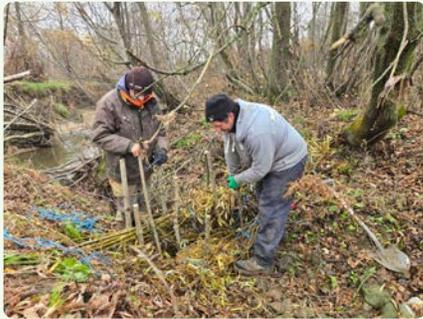
Installation de 416 fagots sur 62 sites pour 187,5 m<sup>3</sup> de sédiment potentiellement retenus par les aménagements
