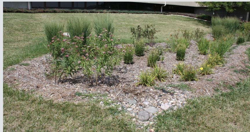
Exemple de renforcement dans ce jardin de pluie situé sur le terrain d'une école. Lorsque le jardin se remplit, l'eau se déverse sur la roche et le gravier et elle n'endommage pas le reste du talus qui la retient dans le périmètre.
