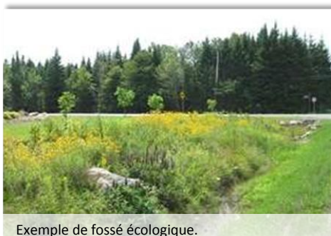
Exemple de fossé écologique. Source : Municipalité des cantons-unis de Stoneham-et-Tewkesbury, 2010
