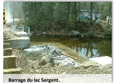
Barrage du lac Sergent. Source : CEHQ (2003)
