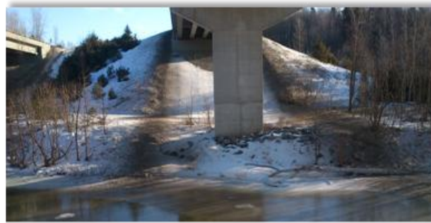
Traînées de sable provenant de l'autoroute au-dessus de la rivière Portneuf. Source : CAPSA, 2013
