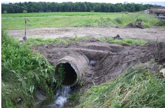
Obstruction à la montaison du poisson (B.V Grand Ruisseau) Source : CAPSA (2014)
