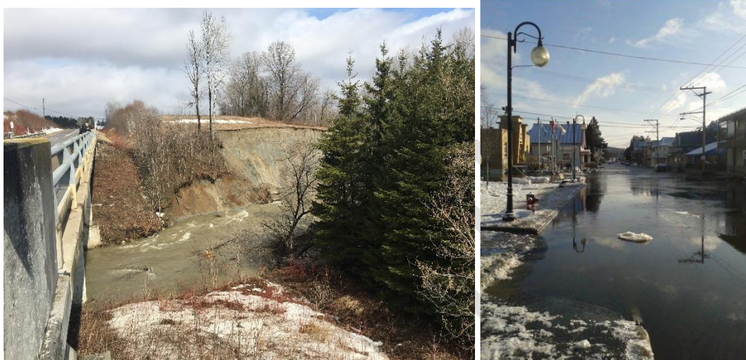
Photo 1 : Glissement de terrain rivière Noire (à gauche, St-Alban, 2022, source : Capsa). Inondation à Saint-Raymond 2014 (Capsa)
