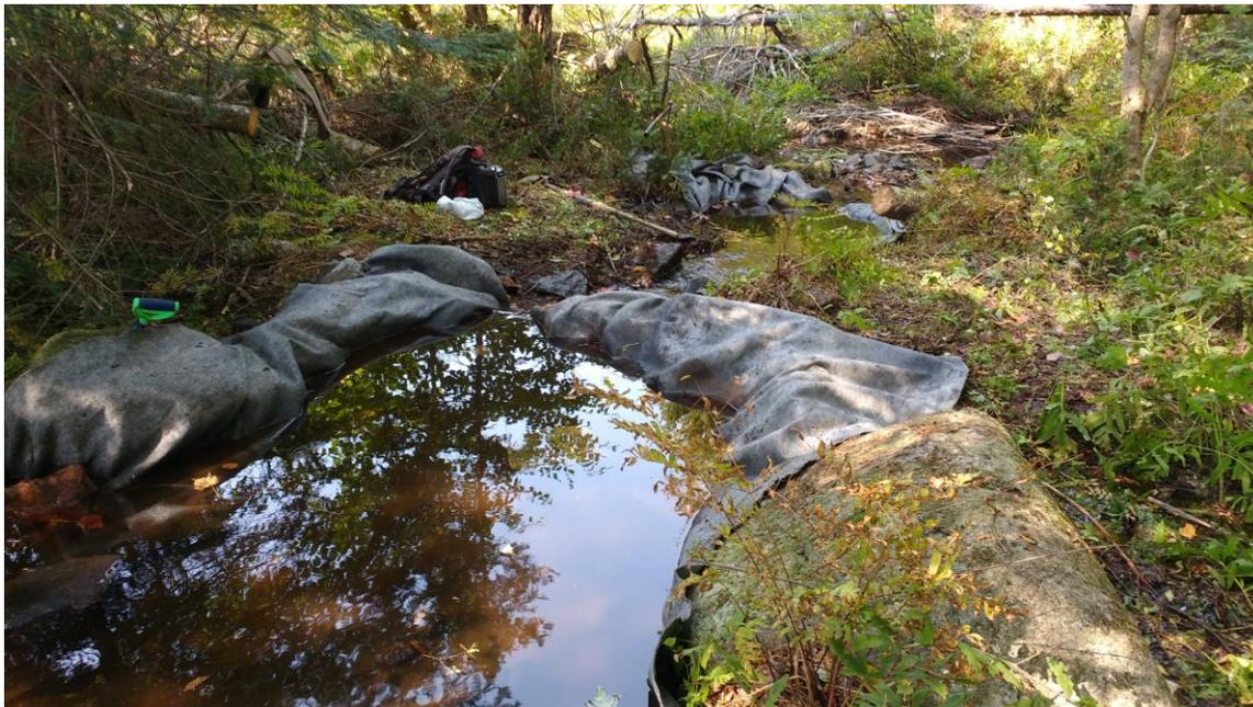
Figure 9 - Lors de la mise en place du géotextile, le lit du cours d'eau doit être uniforme, sans aspérité. C'est cette membrane qui permet l'étanchéité et incidemment, la retenue d'une colonne d'eau intéressante (30 cm environ) pour l'habitat du poisson.
