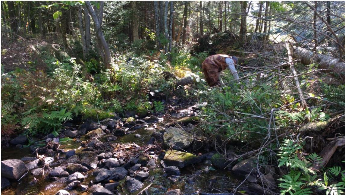
Figure 3 - Vue du cours d'eau avant la construction d'un seuil ; Un nettoyage de débris ligneux a préalablement été effectué. Puis, les pierres naturelles présentes sur le site ont été dégagées et réutilisées le plus possible lors de l'aménagement des seuils.
